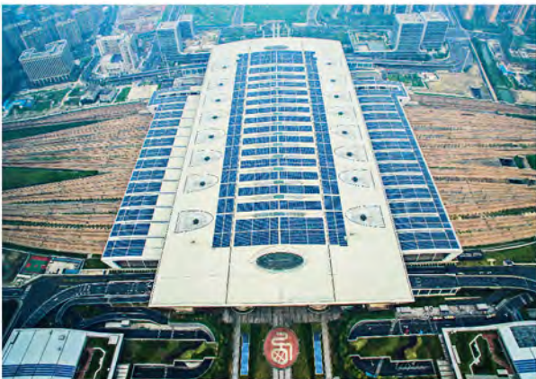
杭州东枢纽太阳能光伏屋顶项目
